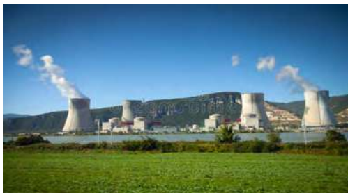
Des. 45. Centrala nucleară din Moselle (Franța)
