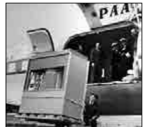
Így nézett ki az első merevlemez. Tárolókapacitása mindössze 5 MB volt.
